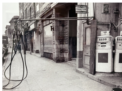
Pompe à essence - ancien style en 1921 (Garage Chez Racicot) rue St-Jacques
